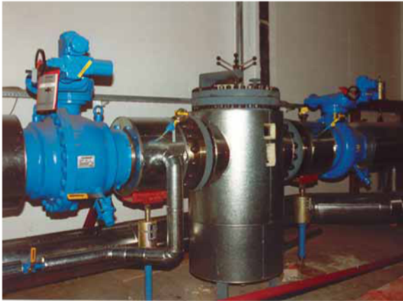
Шаровой кран КНИ в теплосети
