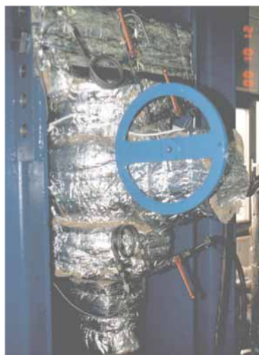
Шаровой кран «Баллостар»: испытание по EN 488
