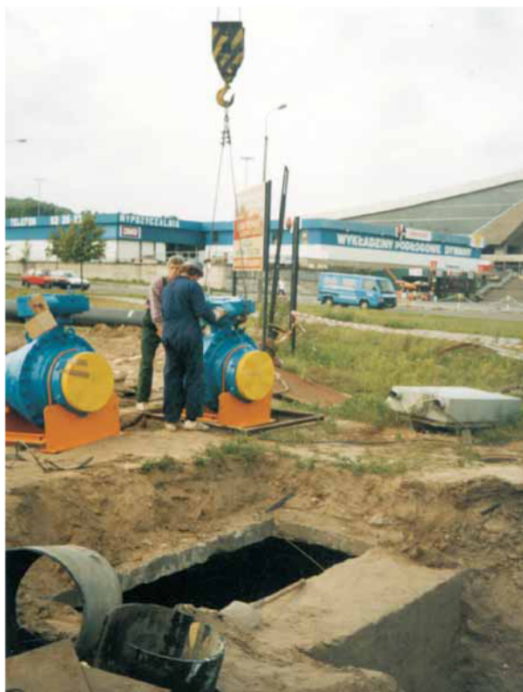
Установка шарового крана «Баллостар» KHSVI в Польше
