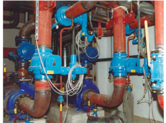
Шаровой кран КНИ в теплосети
